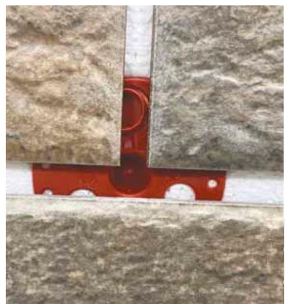
Abbildung 2. Eingelassenes Element in der Klinker-Thermoplate
